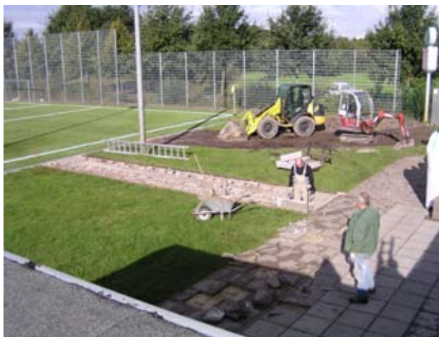
Das Foto zeigt noch Restarbeiten am Gehweg zum Platz (Bordstein setzen) und Austausch von beschädigten Gehwegplatten auf der Terrasse. Die Baufläche ist fast vollständig abgetragen.
